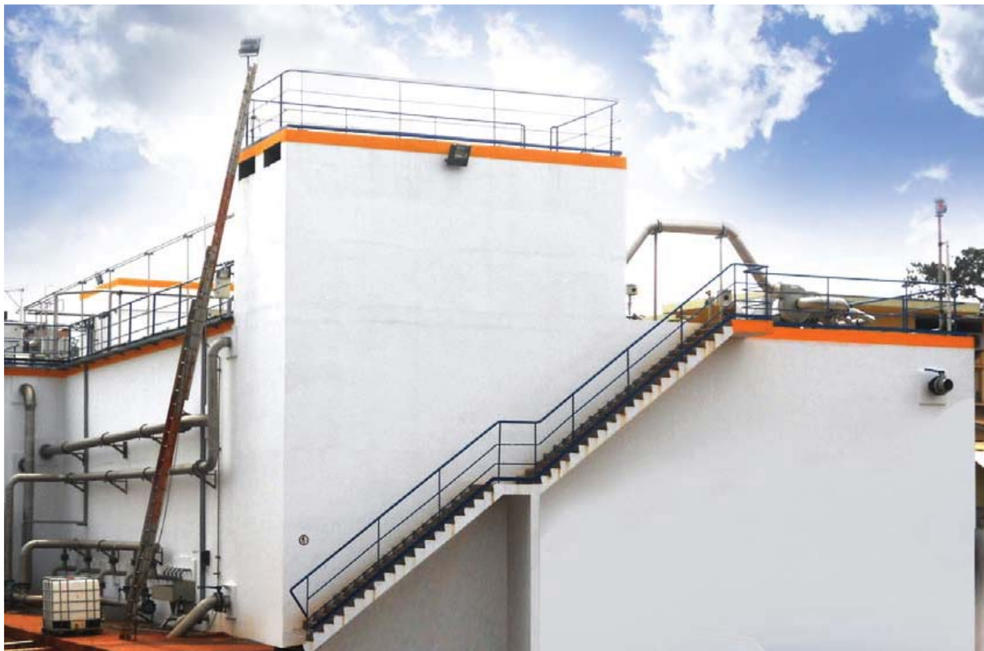
La station d'épuration des eaux usées de Yaoundé
